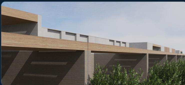
Vuelo de cubierta y celosía OBRA NUEVA • ALTA EFICIENCIA
