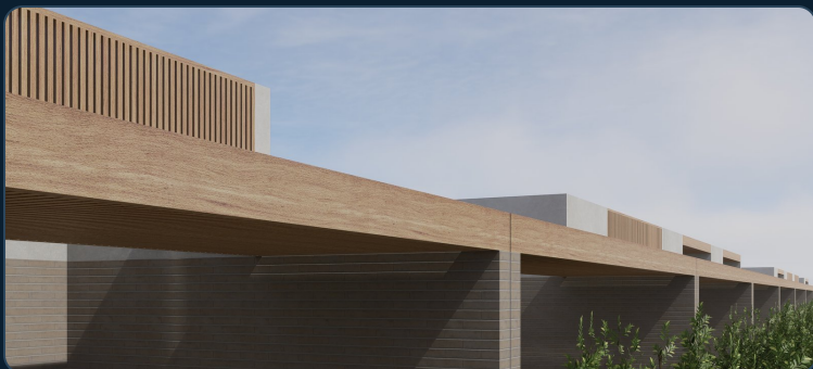
Celosía de madera y ladrillo en fachada
